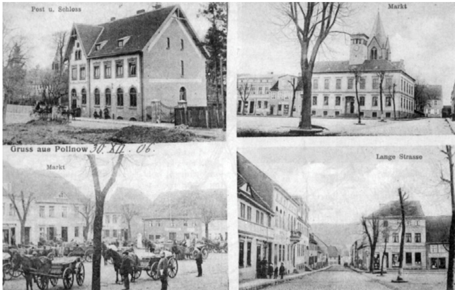
Ryc. 6. Polanów, rynek z ratuszem, Langestrasse (ul. Zamkowa), poczta, widokówka Gruss aus Pollnow , 1906, (Heiseler 1989: 675)
