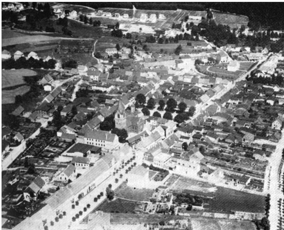
Ryc. 1. Polanów. Widok z lotu ptaka od południowego zachodu, fotografia z około 1930 roku, (Heiseler 1989: 681)
